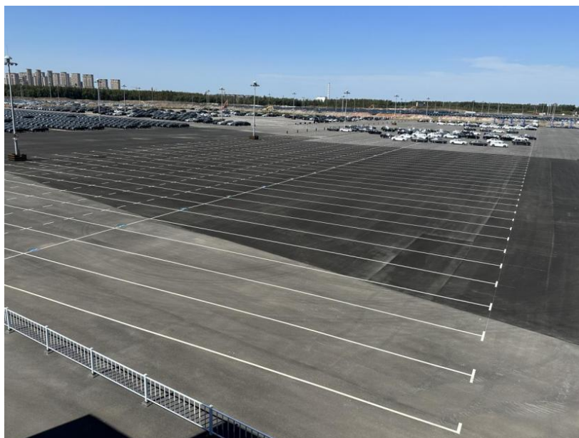
图 14-8 备车道区域现场全景图
